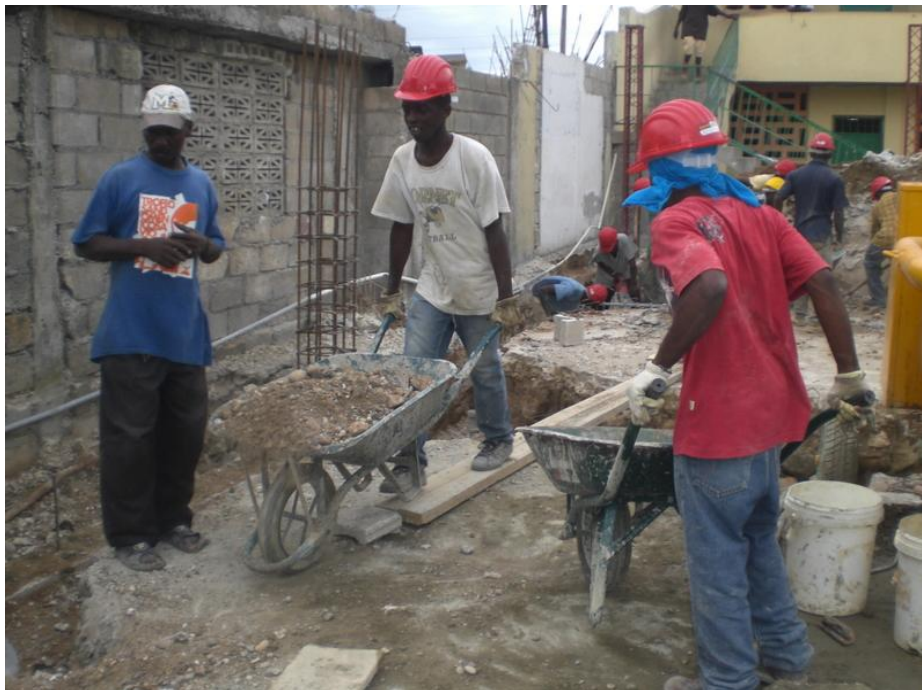
Le chantier à l'école
